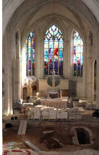
Chapelle de l'Immaculée Conception à Nantes Suivi archéologique des travaux de restaurations avec fouilles de caveaux et analyse des différentes étapes de construction de l'édifice .
